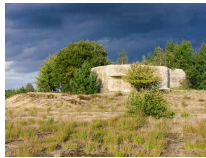
Bunkry na wrzosowiskach w Puszczy Małomickiej (Nadleśnictwo Świętoszów)
